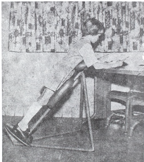
Konstrukcija naslona namijenjenog za učionice pored običnih stolica. Omogućuje osam različitih položaja za nemoćnu djecu. Dizajner Steven Lynch, student univerziteta Purdue.
